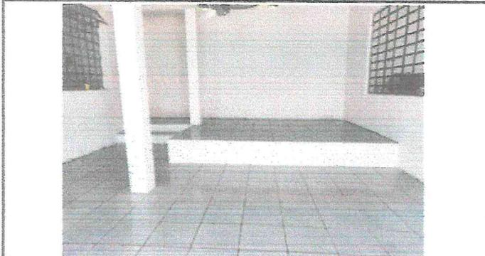
Foto1: Foto1: . Esta parte es el corredor de ambas aulas, se aprovecho a agrandar el escenario colocandoles piso ceramico y ampear la pared del fondo.
